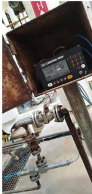
针对我国当前地表水、饮用水源中挥发性有机物[VOCs]在线监测需求，谱育科技自主研发了EXPEC2100水中挥发性有机物在线监测系统[EXPEC2100水中挥发性有机物在线监测系统集自动进样、在线吹扫、富集、解吸、色谱分离、质谱检测 and 数据处理于一体，可无人值守下连续运行，准确测量水中VOCs浓度，实时远程传输测量结果，实现水体VOCs污染程度的监测与预警。系统原理系统将水样采集并送入吹扫装置，然后向吹扫腔中通入吹扫气体，将待测水样中VOCs组分吹出，将VOCs富集在吸附管中，然后采用热解吸的方式将样品从吸附管中解吸出来，由载气带入色谱柱中进行分析，经过分离后的样品进入到质谱检测器中被分析检测，得到各目标组分准确的定性定量分析结果。系统特点标准分析方法采用国际公认的水中VOCs标准分析方法——吹扫捕集—气相色谱联用法恒温吹扫1. 恒温吹扫技术，吹扫效率高，吹扫气用量小，维护周期长，维护成本低。驰光机电交通便利，地理位置优越。湖南盐酸中游离氯浓度分析仪表多少钱
